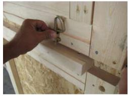
Install barrel bolt.
